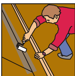
Au besoin appliquer le Primer sur les panneaux avec un pinceau ou un rouleau
