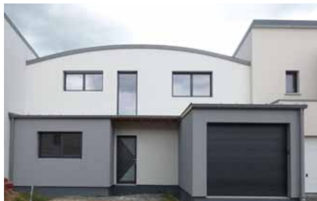
Une maison mitoyenne moderne et parfaitement isolée (Ille-et-Vilaine)
