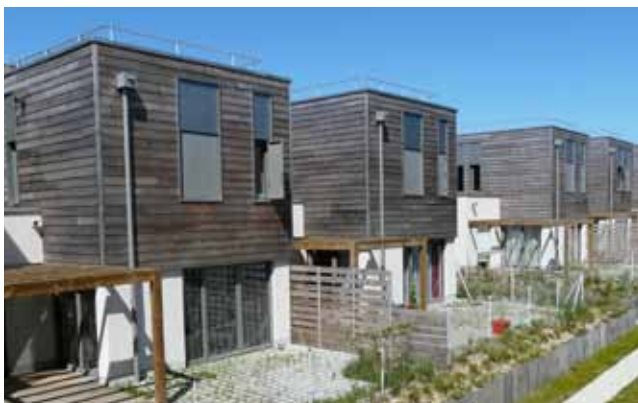
Mixité crépi et bardage pour l'internat du Lycée Sud Loire à Clisson (Ataub Architecte - Conseil Régional des Pays de la Loire)
