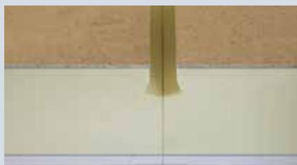
Une rainure en queue d'aronde, à mousser avec du polyuréthane en bombe, garantit la liaison entre les panneaux.
