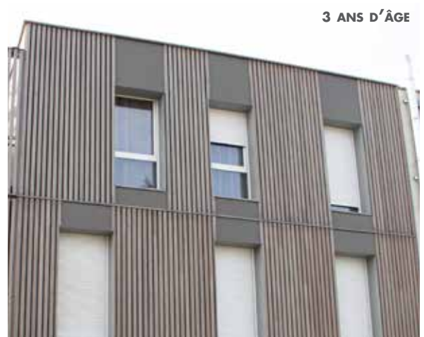
Mélèze de Sibérie - Trapézo - 27x70 - gris 102 © Pierre Vallet/Brière Architectes (74)
