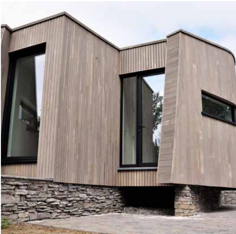
Western red cedar, abouté - Chanfréa - 18x130 et Parallélo 30 - 18x70 - gris 102 Architecte : Grégory MILQUET - Entreprise : ATRIA
