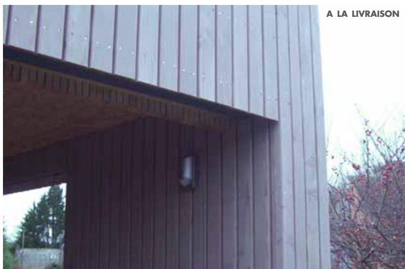
Douglas - Trapézo - 27x70 - gris 102 - Extension et requalification d'une entrée - Fabien PLAUD Artisan (56)
