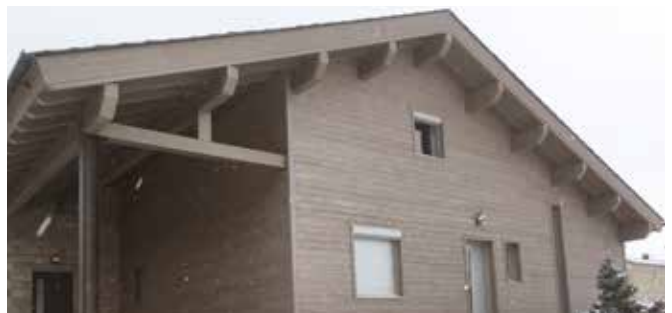
Pin du Nord, EcoThermo extérieur - Elégia - 20x125 - gris 102 Extension d'atelier (66) - Constructeur Stéphane TESSONNEAUD (66)
