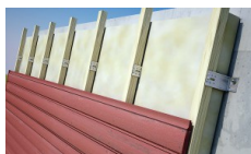
Mise en place éventuelle d'un pare-pluie
