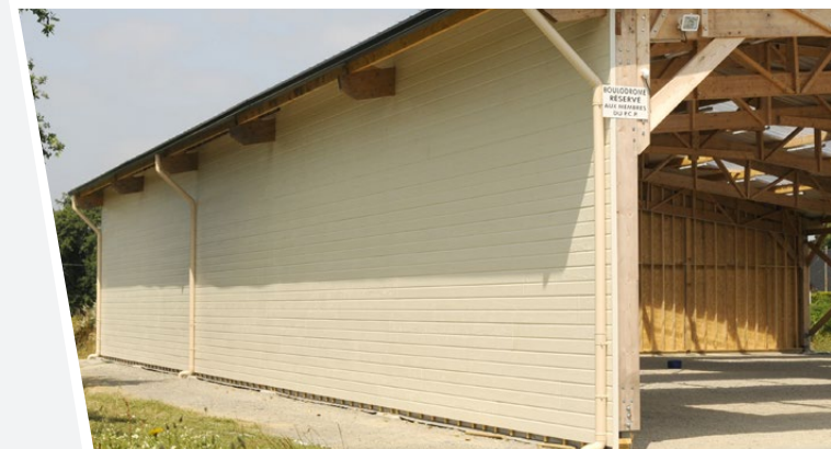
Bardage Néo Ivoire - Boulodrome à Pont-Château (44)
